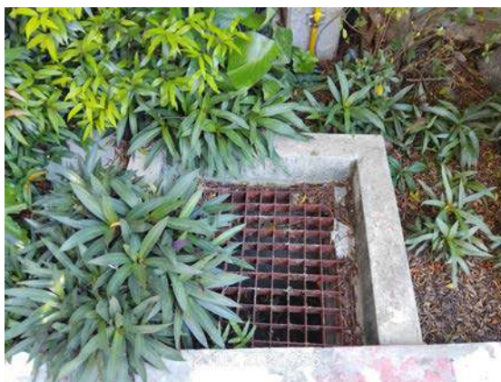
รูปที่ 2.41 ตะแกรงดักขยะ
