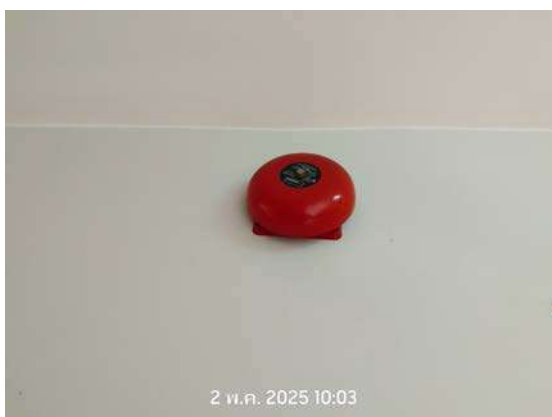
รูปที่ 3.39 สัญญาณแจ้งเตือนเหตุเพลิงไหม้
