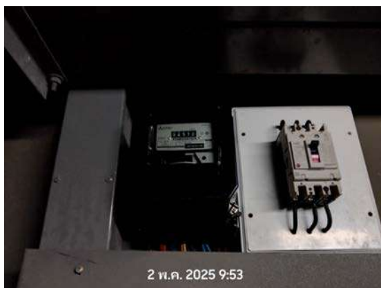
รูปที่ 2.45 มิเตอร์ระบบบำบัดน้ำเสีย
