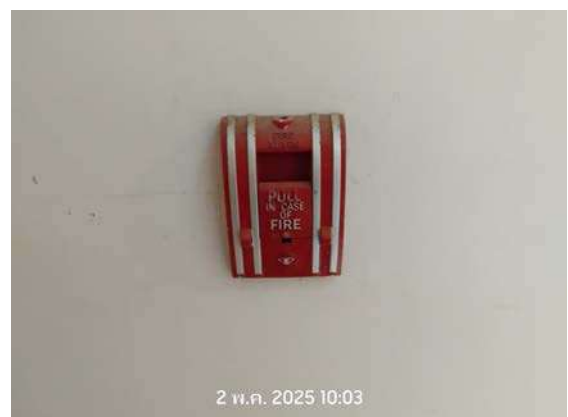
รูปที่ 3.39 สัญญาณแจ้งเตือนเหตุเพลิงไหม้
